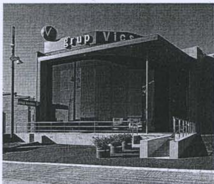
Sede de Grup Vicsan, en Torredembarra (Tarragonés).
