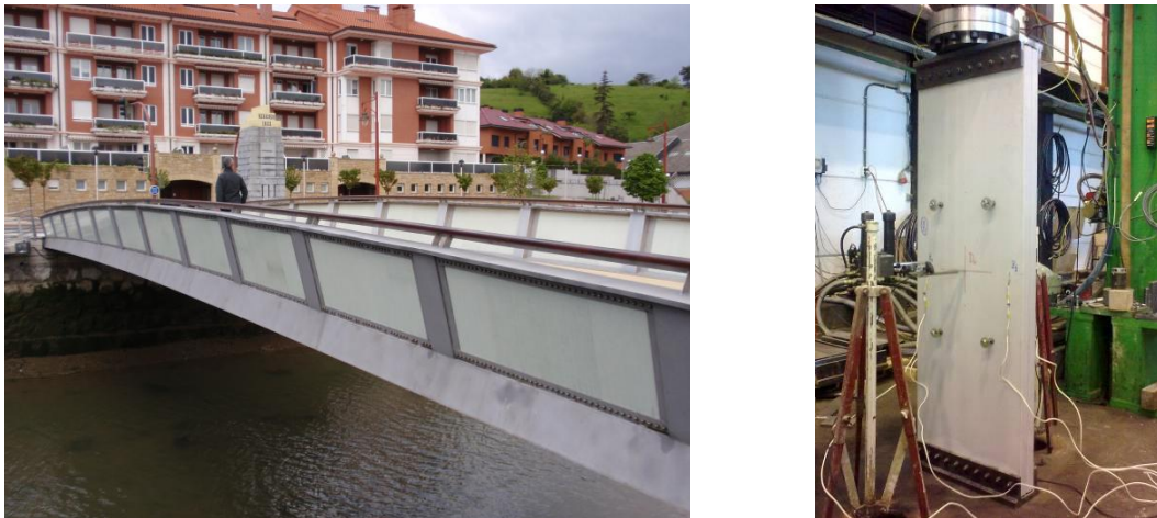
Figura 4-2. Imagen (a) los paneles situados en el puente sobre la ría Narrondo (Zumaia) y en (b) un panel ensayado por el IETcc.
