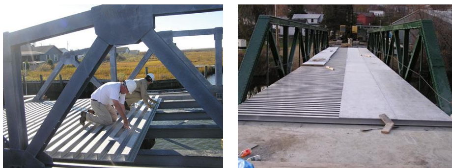
Figura 3-11. Figura (a) muestra la colocación del tablero por parte de los trabajadores y en la figura (b) el puente con la actuación completa.
