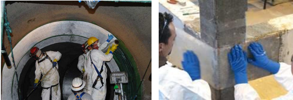
Figura 3-9. La figura (a) muestra el revestimiento de un túnel y en la figura (b) un refuerzo de una columna mediante un tejido de material compuesto externamente adherido.
